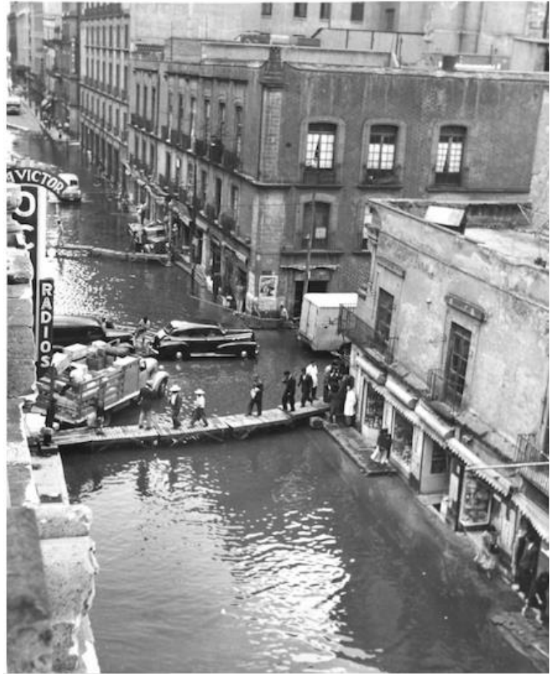
Inundaciones en el centro de la Ciudad de México (1952). Fuente: El gran reto del agua en la Ciudad de México. SACMEX
