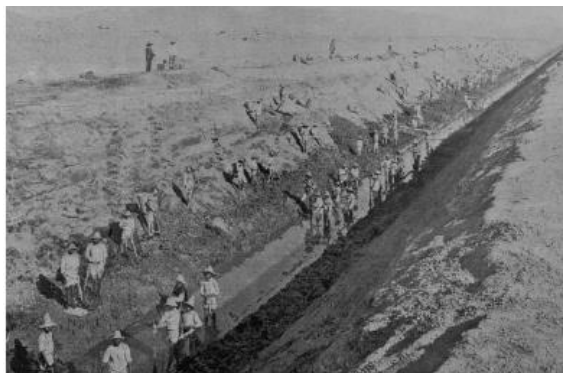
Figura 13. Construcción del Gran Canal, km 7. Fuente: El gran reto del agua en la Ciudad de México. SACMEX
