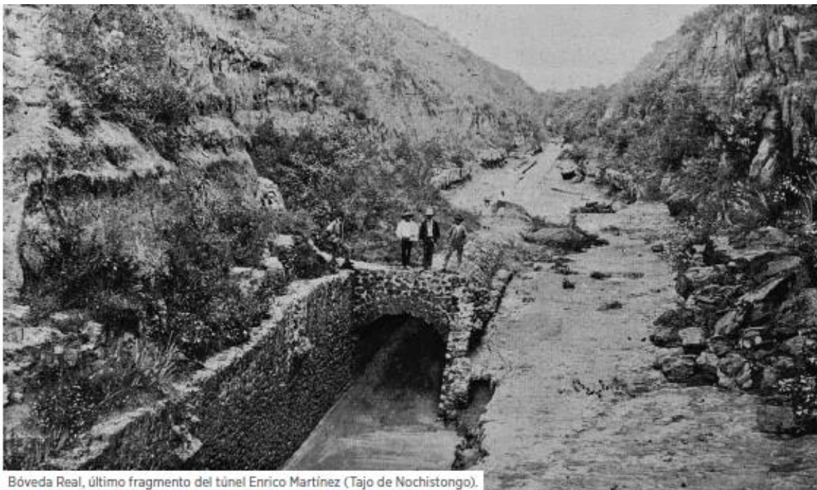
Figura 6. Galería de Nochistongo. Fuente: El gran reto del agua en la Ciudad de México. SACMEX
